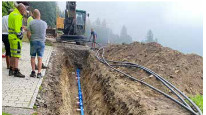
Zusammenschluss der Ringleitung
