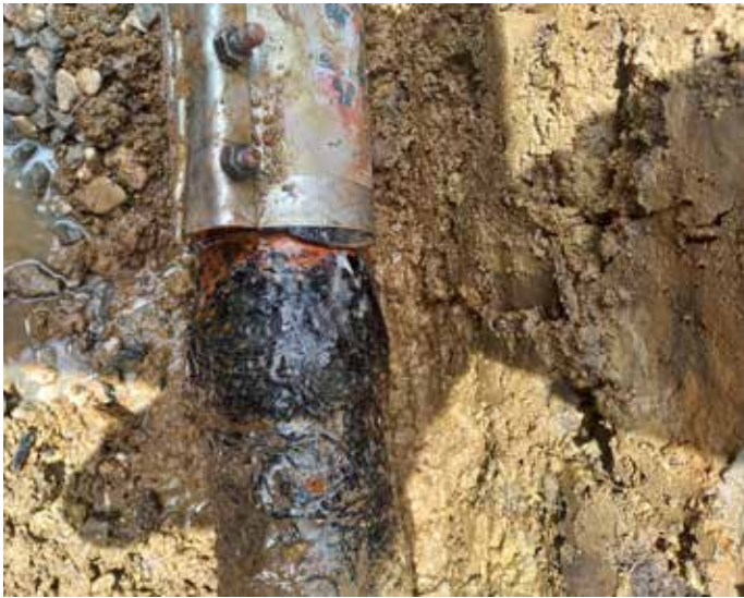
Wasserverlust durch beschädigte alte Leitung
