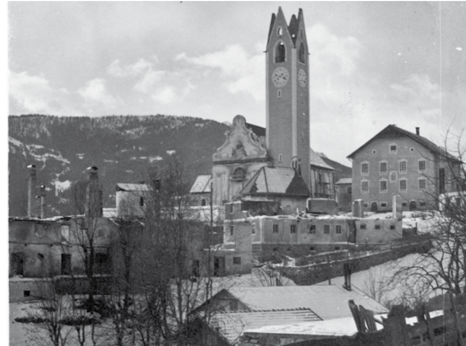
Die beschädigte Pfarrkirche und die abgebrannte Hausreihe am „Langenbichl“.
