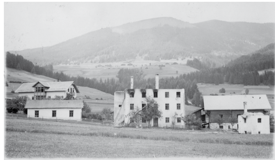
Das alte Schulhaus: das Dach und das Obergeschoß wurden ein Raub der Flammen. Rechts daneben „Plösch“.
