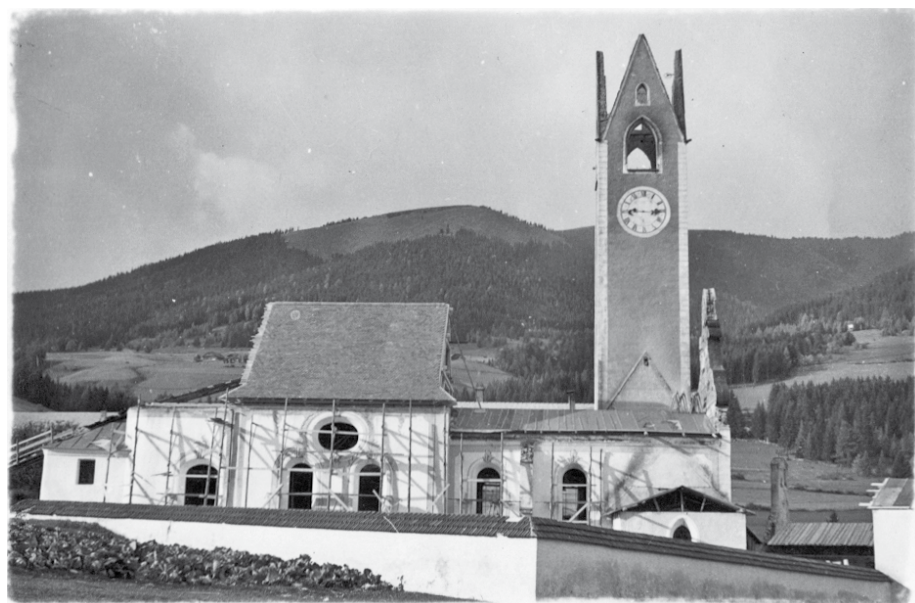
Nach dem Brand: Kirche und Turm ohne Bedachung.
