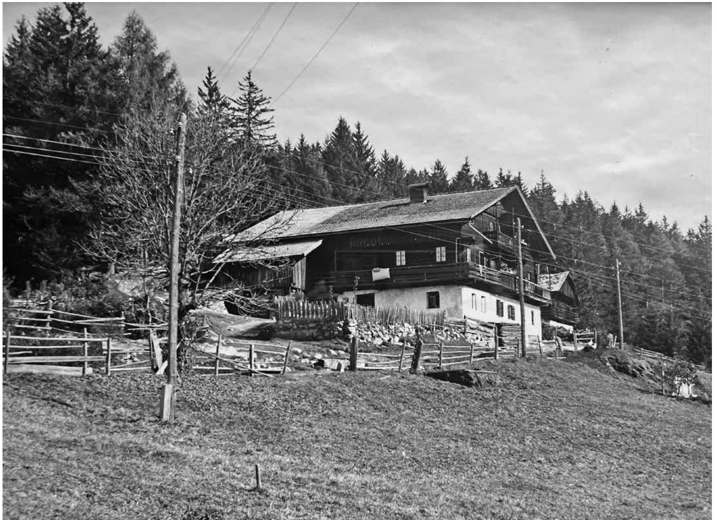
Südwestansicht des „Klompra“; im Vordergrund der Anteil von „Ratza“
