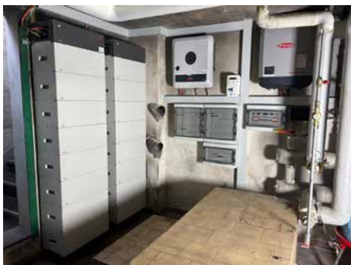
Installation einer PV-Anlage mit Batteriespeicher
