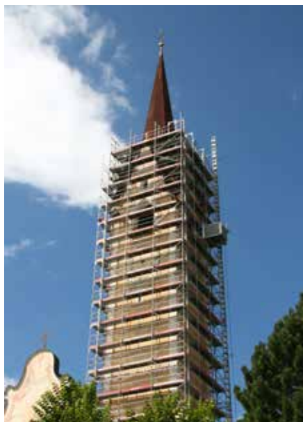
Kirchturmsanierung und Neubau des Glockenstuhles mit Elektrifizierung des Geläutes
