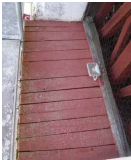
Morsche Fensterbankabdeckung vom Schallfenster vor der Restaurierung
