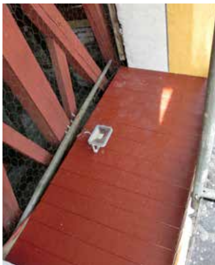
Neue Fensterbankabdeckung vom Schallfenster nach der Restaurierung
