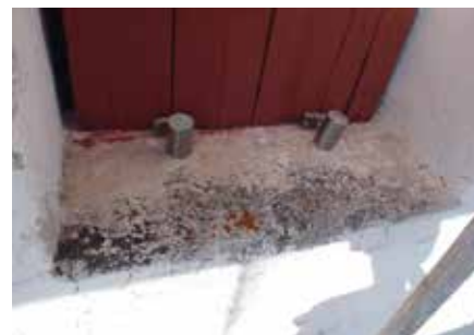
Morsches Turmhelmfenster ohne Fensterabdeckung vor der Restaurierung
