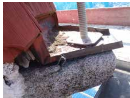
Wasserspeier mit zu geringer Kupferblechaufkantung vor der Restaurierung
