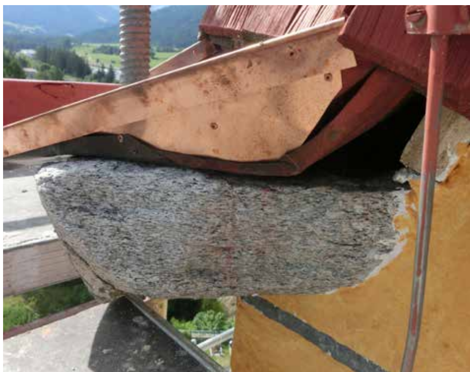
Wasserspeier mit erhöhter Kupferblechaufkantung nach der Restaurierung
