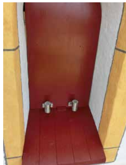
Neues Turmhelmfenster mit Fensterabdeckung nach der Restaurierung
